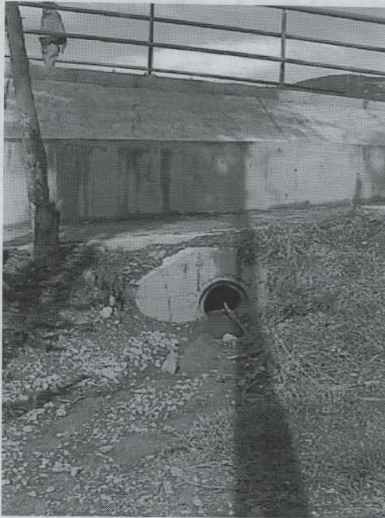
FOTO 1. Calle 197 carrera 40A. Cabezal de la tubería de \phi 14'' que conduce las aguas lluvias hacia el sistema de alcantarillado que está ubicado bajo la cicloruta occidental del Canal Torca.
