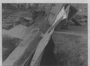
Fotografías 1 y 2. Deslizamiento que afectó la esquina de la cimentación en el predio de la señora Vargas.
