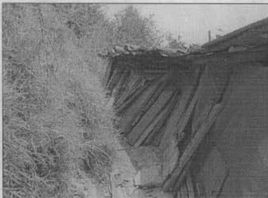
**Fotografía 1.** Parte lateral (costado oeste), nótese la inclinación de la estructura debido a empujes del material acumulado en esta zona.
