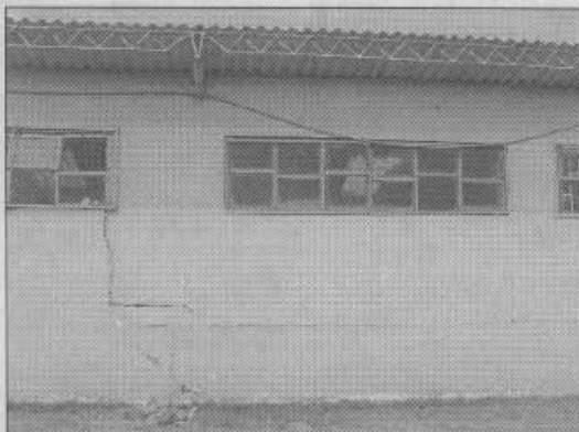
Fotografía No. 1 Vista exterior del bloque afectado por asentamientos
