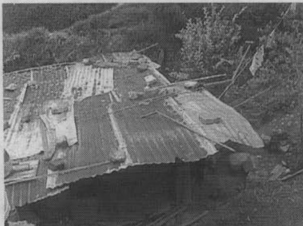
**Foto 14.** Casa con características similares a la anterior, construida en madera y latas con cubierta en teja de zinc. Está ubicada en la orilla izquierda de la quebrada pero a una cota igual que la que tiene la quebrada en épocas invernales. La vivienda ha presentado afectaciones por inundación en la parte destinada al patio.
