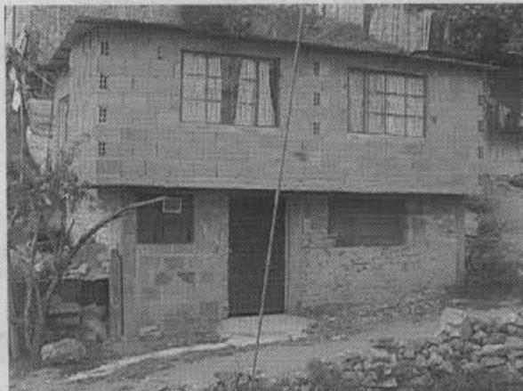
**Foto 5.** Frente a la vivienda se observa un muro de protección hecho en piedra pegada construido por los habitantes de la misma y que sirve para delimitar la vía peatonal en este sector.
