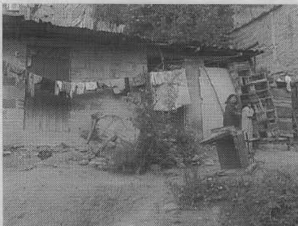
**Foto 11.** Casa construida en mampostería y madera con cubierta en teja de zinc. Está ubicada en la orilla derecha de la quebrada pero a una cota superior que la que tiene la quebrada en épocas invernales. La vivienda no ha presentado afectaciones por inundación ni tampoco por inestabilidad del suelo.
