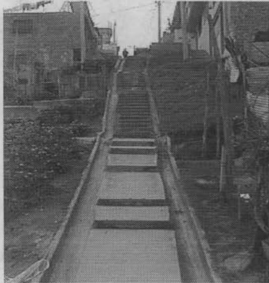
**Foto 4.** Escalera construida aproximadamente hace 10 años, es un acceso peatonal que conduce a las partes bajas del barrio y que cruzan la quebrada Zanjón El Baúl por medio de puentes peatonales. Se observa que no tiene fisuras ni grietas que evidencien movimiento del terreno. El manejo de aguas de escorrentía se hace por medio de cunetas paralelas a la escalera que entrega a la quebrada y que evitan que éstas se infiltren en el suelo.
