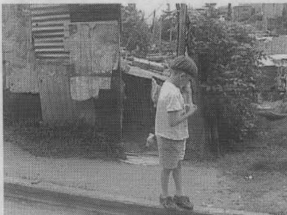
**Foto 12.** Casa construida en madera y latas con cubierta en teja de zinc. Está ubicada en la orilla izquierda de la quebrada pero a una cota igual que la que tiene la quebrada en épocas invernales. La vivienda ha presentado afectaciones por inundación en la parte destinada al patio. Los pisos son en cemento y en algunas partes presentan fisuras por la remoción del terreno debido a la acción de erosión hídrica ejecutada por la quebrada.
