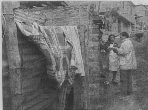
**Foto 3.** La vivienda es una construcción hecha hace 30 años en mampostería, madera, latas y tejas de zinc ubicada en la orilla derecha del caño Zanjón El Baúl pero a cotas superiores a la línea de inundación.
