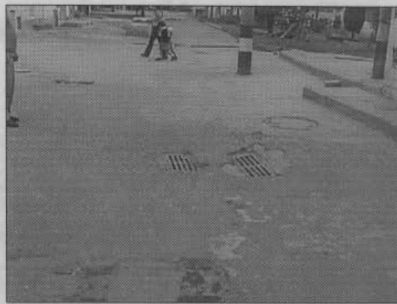
Hundimiento pozo carrera 5°M con calle 49A Bis Sur Hundimiento rejillas calle 49D Bis Sur con carrera 5°M
