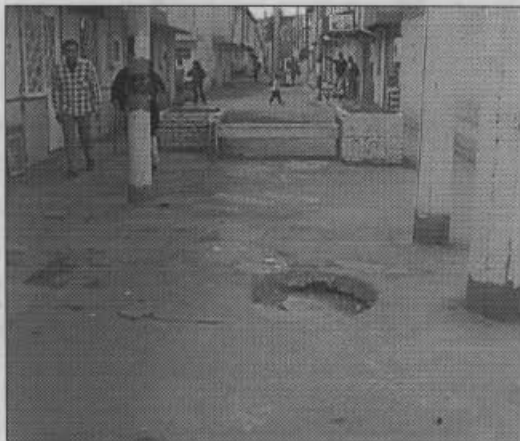
Hundimiento pozo carrera 5°M con calle 49A Bis Sur Hundimiento rejillas calle 49D Bis Sur con carrera 5°M
