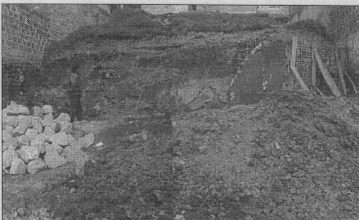
Fotografía No. 4 Vista en sentido occidente - oriente. Se aprecia el grado de intervención y las precarias medidas implementadas para la estabilización.
