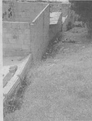
Fotografía No. 3 Vista al sur donde baja la altura del talud hasta coincidir con el nivel de desplante de las viviendas.
