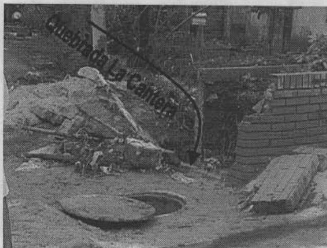
FOTO 3. Daños causado por el desbordamiento de la quebrada La Cantera. La fuerza del agua arrancó el muro de la jardinera arrastrando los pedazos a la mitad de la vía.
