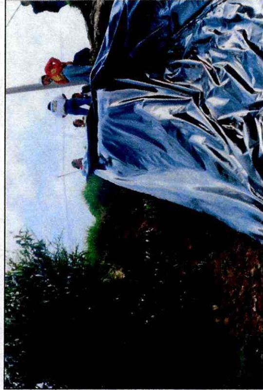
FOTOGRAFIA 2 (R3055F23) CUERPO DEL FLUJO DE TIERRA, PROTEGIDO CON POLIETILENO PARA EVITAR UNA REACTIVACION A CONSECUENCIA DE LA TEMPORADA INVERNAL
