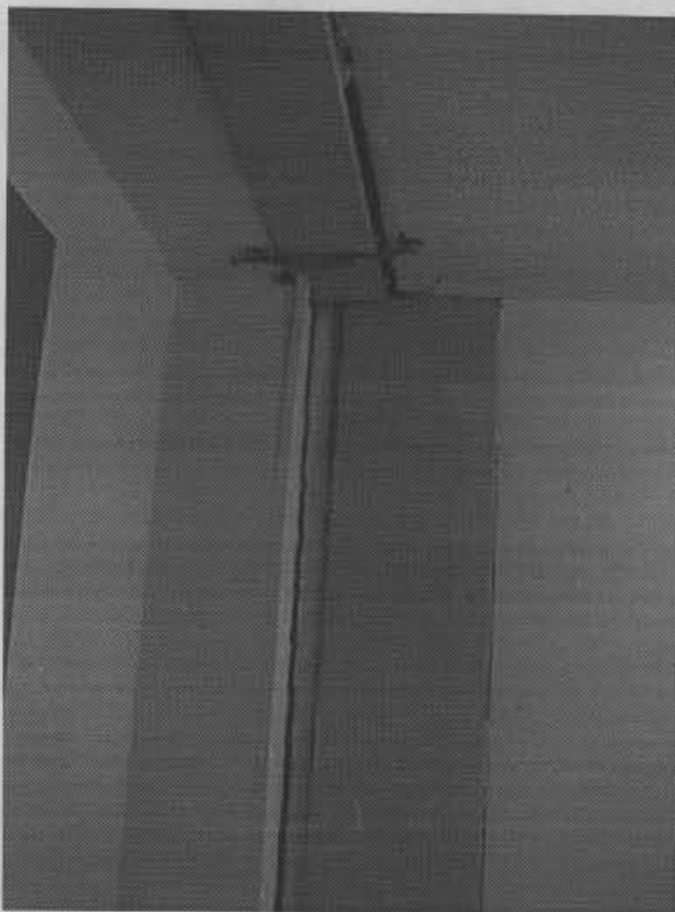
Fotografía No. 1. Salón comunal de la urbanización.
