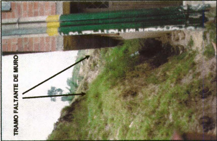
FOTOGRAFIA 2 (R3040F7) VISTA HACIA EL SUROCCIDENTE. LA SEPARACIÓN MEDIA DE LA CASA Y EL TALUD ES DE 1.00 M. SE NOTA AL FONDO, EL TRAMO FALTANTE DE MURO EN GAVIÓN
