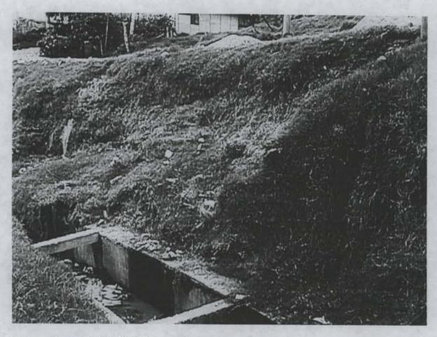
Fotografía No. 2. Detalle del movimiento del terreno en la margen oriental del canal. Se aprecia hacia el extremo inferior derecho de la fotografía el aporte de aguas negras a éste. La carrera 4 Este es la que se ubica en la corona del talud que ha presentado movimiento debido a la saturación de la masa de suelo por la infiltración de aguas lluvias y aguas negras.
