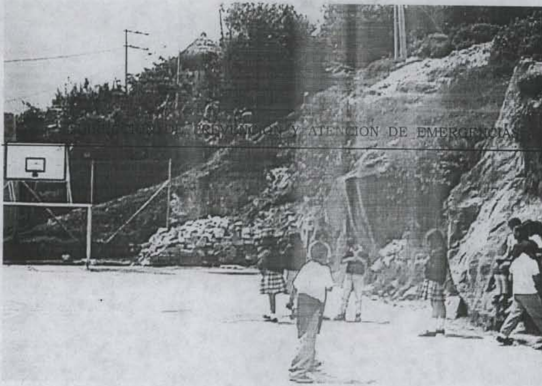
Fotografía No.1. Deslizamiento e la esquina nororiental de la cancha polideportiva del barrio bosques de Bellavista. Se observa que en esta zona aflora una intercalación de estratos gruesos de arenisca friable y más delgados de arcillolita, cuyo buzamiento o inclinación es desfavorable al corte efectuado. Se aprecia también un espesor considerable de capa orgánica negra.
