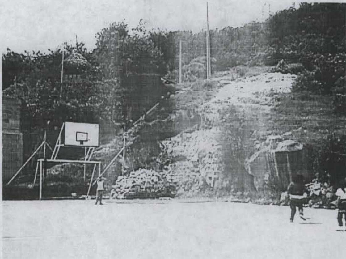
Fotografía No. 2. Detalle del fenómeno de inestabilidad descrito en la fotografía anterior.
