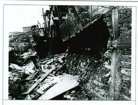
Fotografía No. 2. Detalle de la afectación sufrida por el muro limítrofe entre los dos predios adyacentes a la excavación efectuada y la vivienda ubicada en el interior 2. Como se aprecia, este muro está a punto de colapsar.
