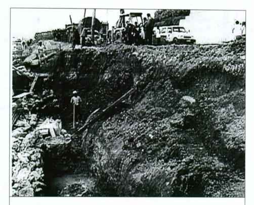
Fotografía No. 1. Se aprecia la excavación efectuada para la construcción de un muro de contención, la cual dejó sin confinamiento ni apoyo a un tubo de 8" que conducía agua potable, lo cual generó que la presión del agua desempatara el tubo, conformándose un flujo de lodos que afectó las viviendas de la parte baja del talud.
