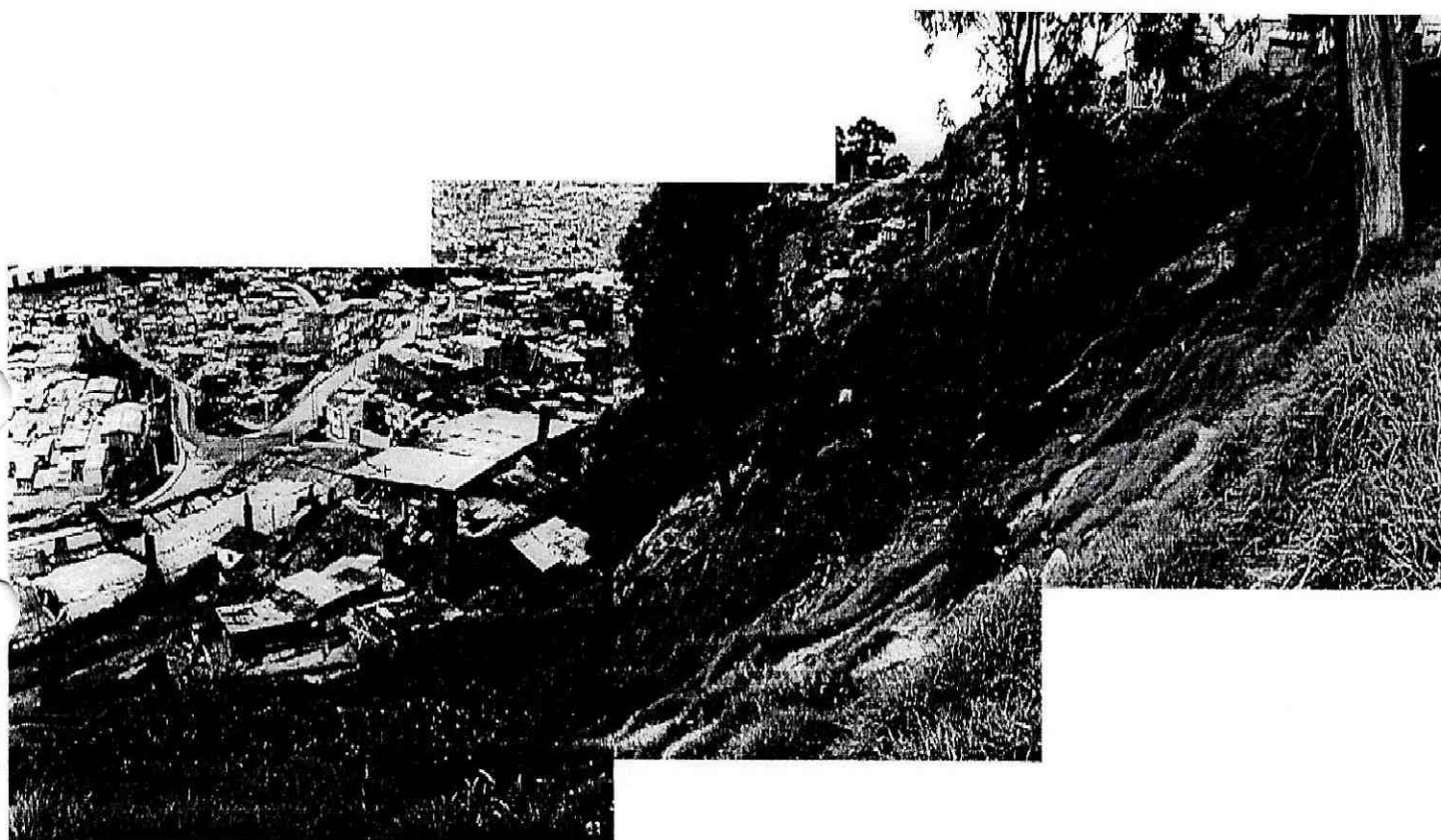
Fotografía 4. Talud de la parte superior de la Fábrica de Tubos Oriente. En la parte inferior se aprecia el inicio de las dos vías de acceso al barrio El Dorado, sector sur - oriental.
