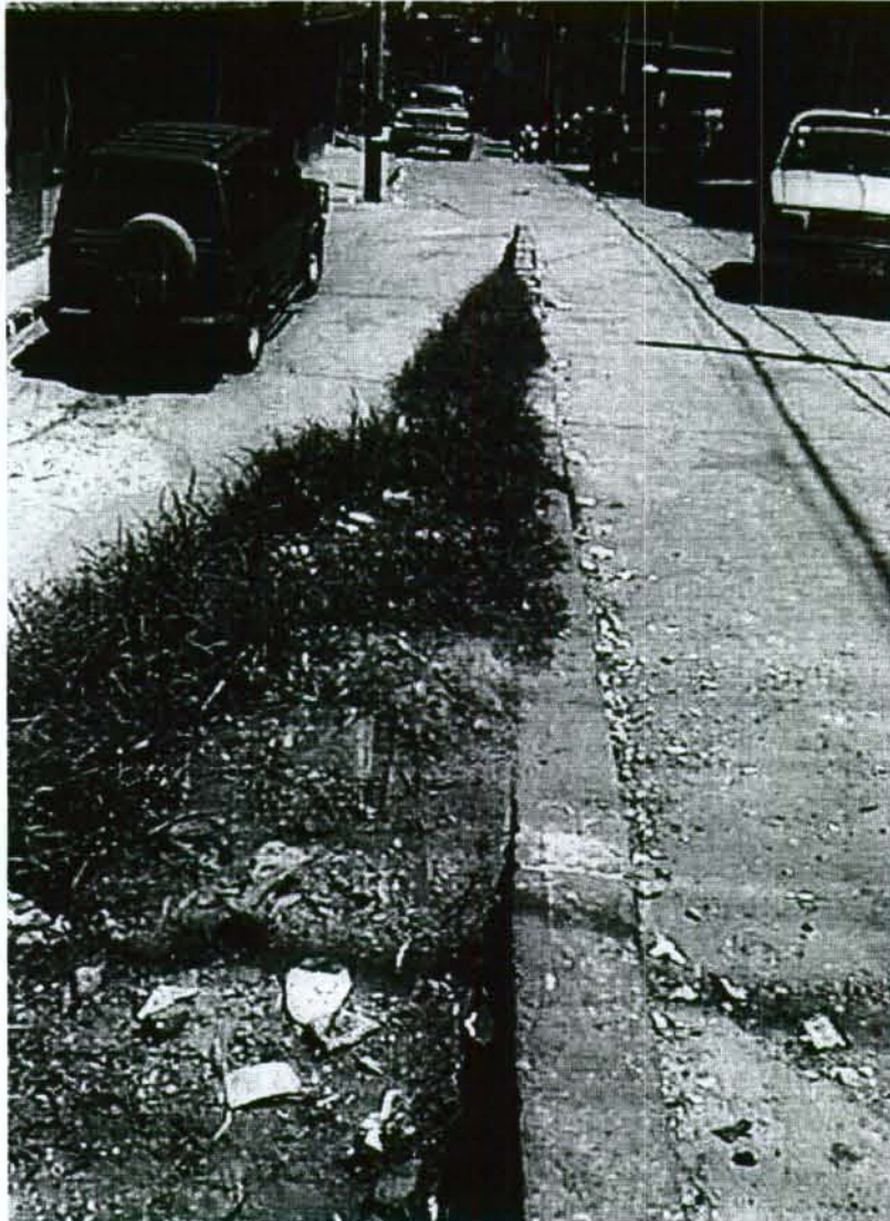
Fotografía No. 3. Vista superior de la transversal 17 B, construida en losas de pavimento rígido.
