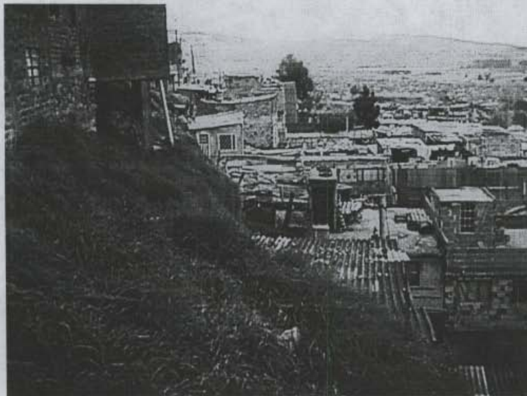
Fotografía 2. Vista del macizo rocoso desde la parte superior. Se observa la descarga de las tuberías de drenaje hacia el sistema existente a lo largo de la corona del talud. Se observa el recubrimiento de la cobertura vegetal.
