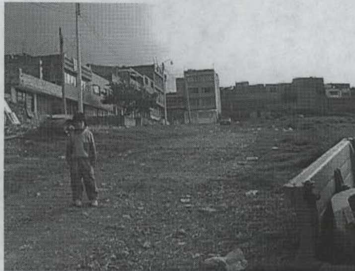
Fotografía 1. Vista desde el inicio de la vía en la calle 22 sur y hacia la parte superior del barrio Granada Sur en la calle 21 sur, corona del deslizamiento.
