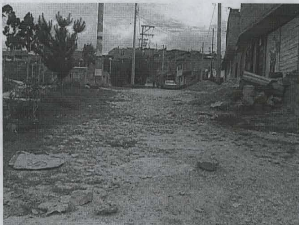
Fotografía No. 2. Detalle de la vía superior al talud observado en las fotografías anteriores. Sobre esta vía no se apreciaron evidencias actuales de fenómenos de inestabilidad del terreno.
