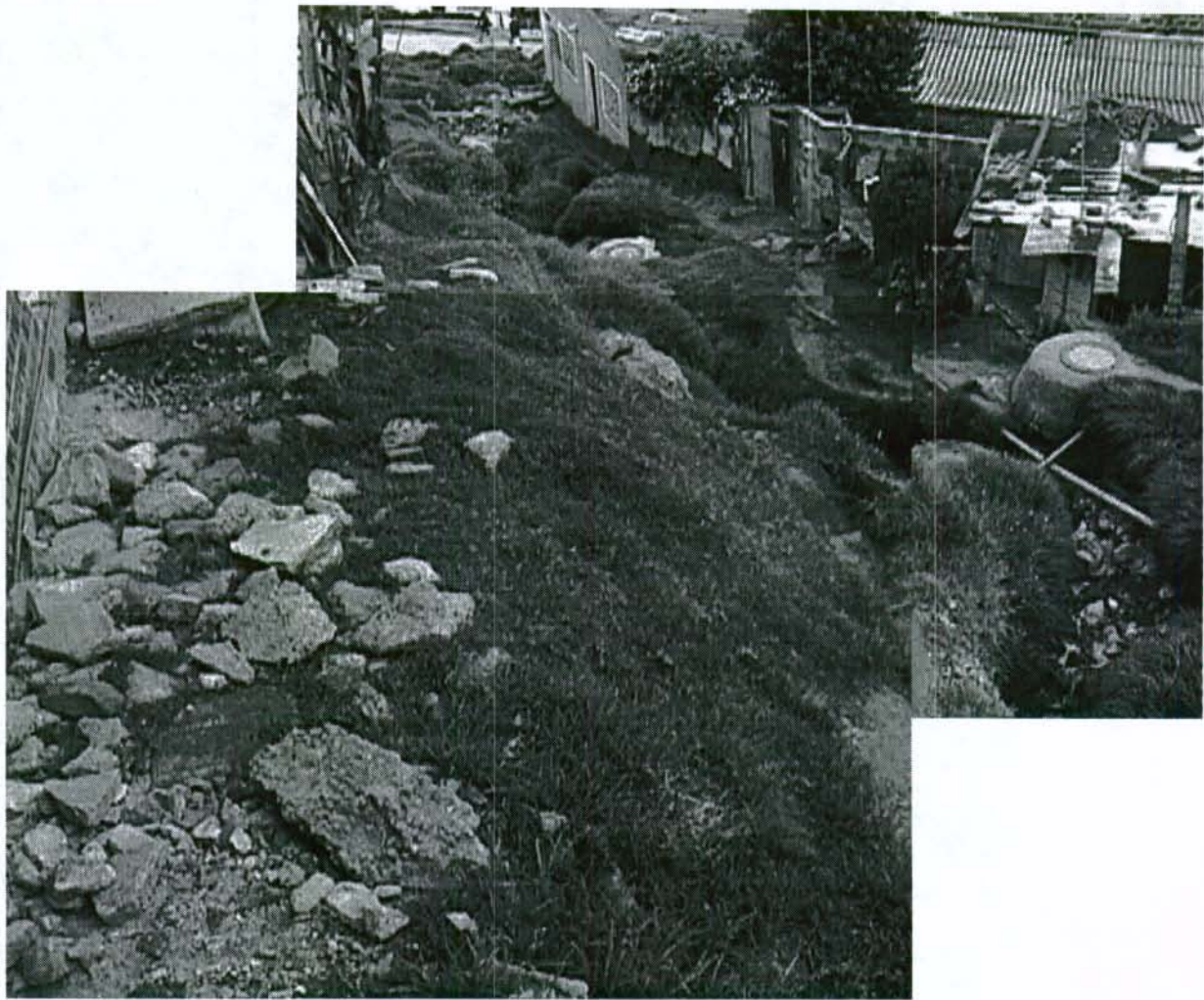
FOTOGRAFIA 3. Vista desde la parte superior del talud, se aprecia el camino de entrada a las viviendas y la distancia de la vivienda hacia la corona del talud.
