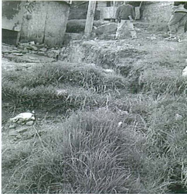
Foto 3. Barrio Santa Helena - foto tomada el 19 de Octubre de 2000 Calle 68 B Sur con 86. Grietas en el terreno y escalonamiento de aproximadamente 1 m de altura.
