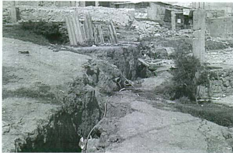
Foto 1. Barrio Santa Helena - Calle 68 C Sur Con Carrera 86. Tomada el 19 de Octubre de 2000. Se observa el escarpe de falla.
