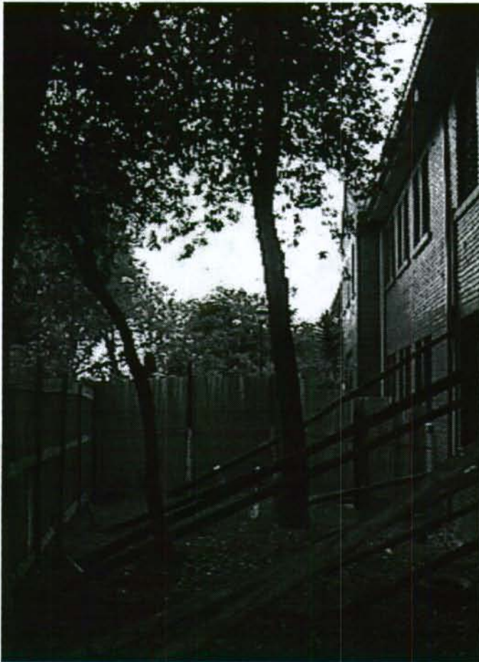
FOTO No.6: Cercanía de los arboles con la edificación.
