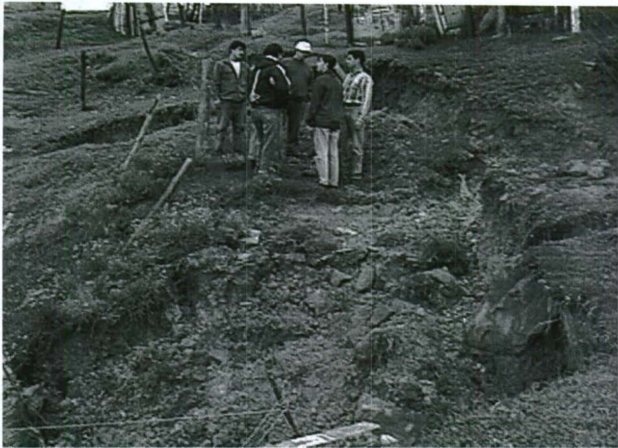
Fotografía No. 5. Se puede apreciar el deslizamiento ocurrido en la parte baja de la ladera, en donde el agua se constituyó en el factor detonante, al saturar la masa de suelo potencialmente inestable, ocasionando su movimiento. Parte de esta masa deslizada fue la que derribó el muro de la vivienda situada en el sector bajo de la ladera.
