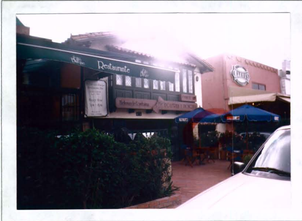
FOTO No. 1. Vista de los restaurantes El Café del Parque – Helena de Lombana Postres y Ponques y Mamma's. Se alcanza a observar la caseta que contiene los cilindros de gas (círculo rojo).
