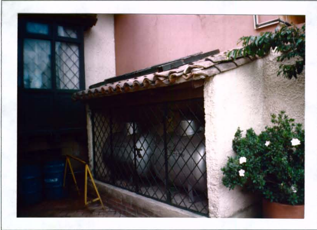
FOTO No. 2. Detalle de la caseta que contiene los cilindros de gas en el restaurante El Café del Parque – Helena de Lombana Postres y Ponques.
