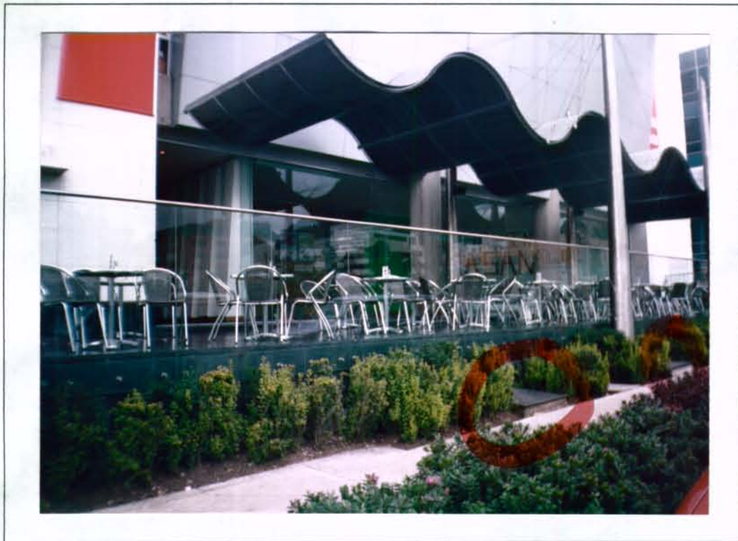
FOTO No. 4. Vista del restaurante Mario Opazo en el primer piso del edificio Portobelo. Se alcanzan a observar las tapas de los tanques subterráneos de Gas que posee el edificio (círculos rojos).
