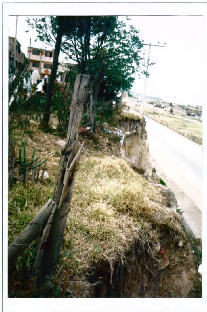
Fotografía No. 3 Detalle de la corona del talud.
