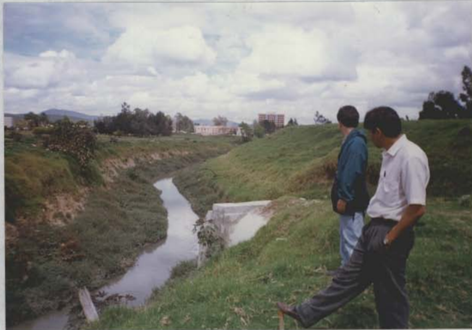
FOTO 3. Vista del Canal Torca que conduce las aguas negras y lluvias del sector y que limita con el proyecto de vivienda.
