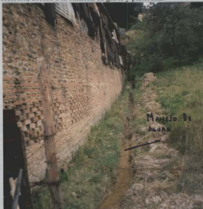
FOTOGRAFÍA 5. Las instalaciones de la fábrica están conectadas a la red de Acueducto y Alcantarillado de Santa fe de Bogotá. Las aguas lluvias se recogen y transportan por cunetas o zanjas realizadas artesanalmente.
