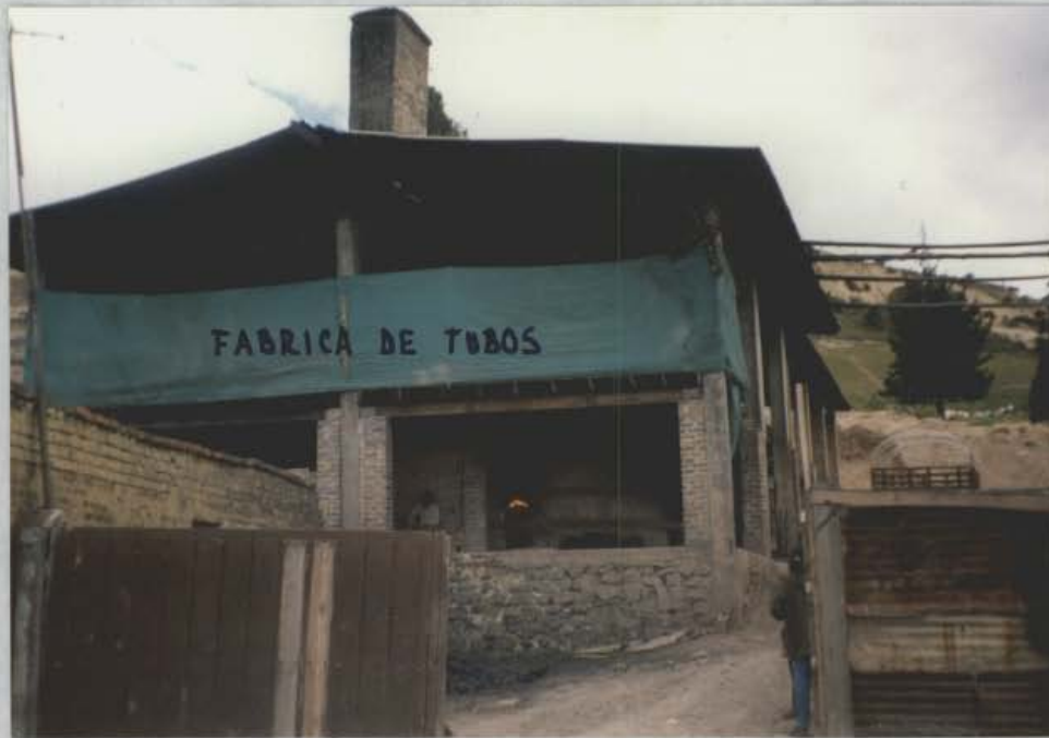
FOTOGRAFÍA 4. La fábrica tiene un proceso artesanal para la producción de tubos, cuenta con dos hornos para la cocción, los cuales usan carbón como materia prima para su funcionamiento. Se observan problemas de contaminación atmosférica, debido a la emisión de gases y partículas.
