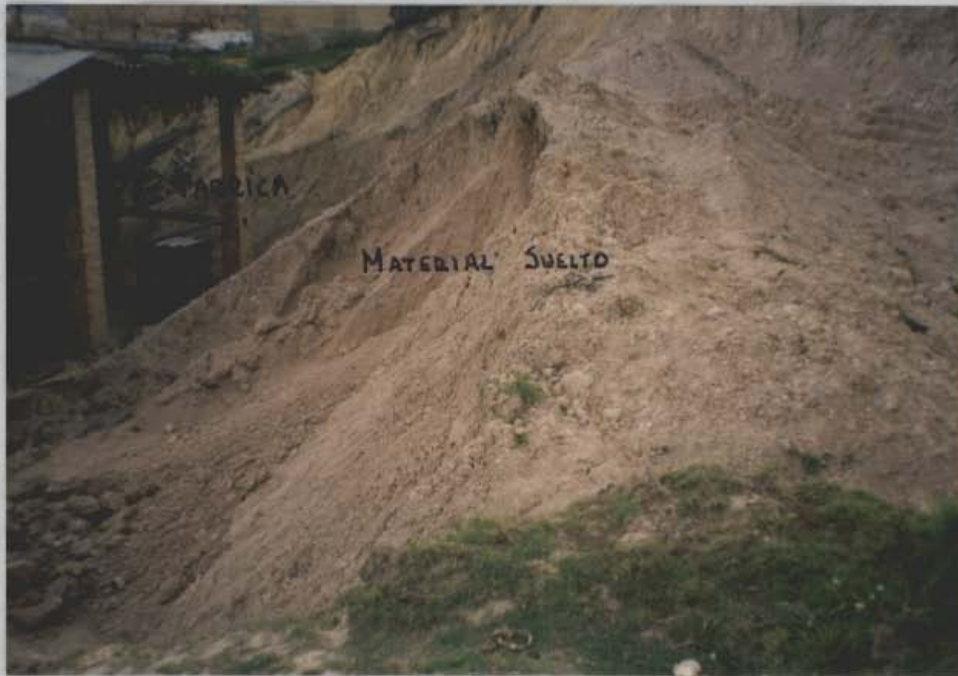
FOTOGRAFÍA 1. Se observa un talud vertical de aproximadamente 2 m de altura hacia el costado posterior de la Fábrica. Hacia la base del mismo se presenta material suelto sin ningún tipo de control.
