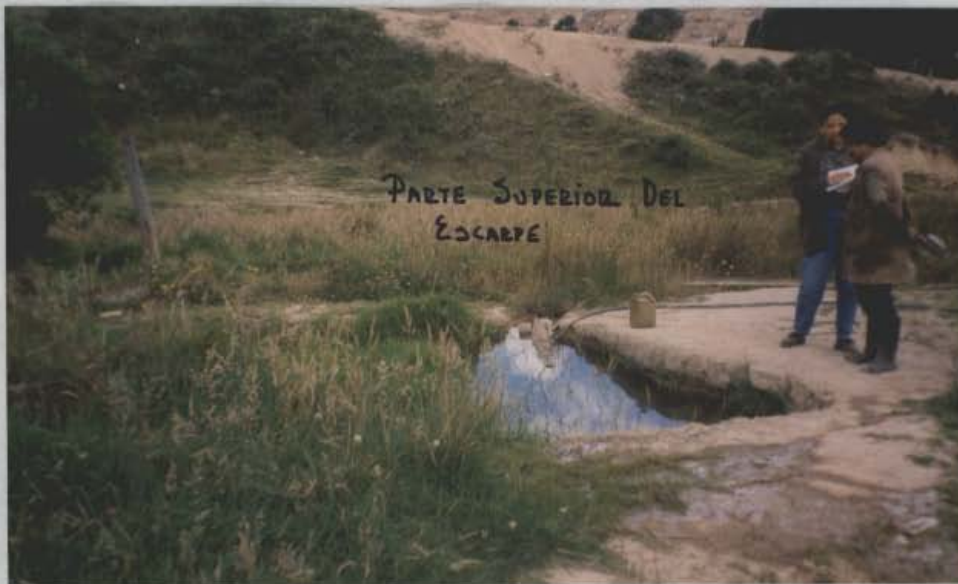
FOTOGRAFÍA 3. Hacia la parte posterior de la fábrica se observa una poceta de aproximadamente 2 metros de profundidad, la cual no se encuentra señalizada, ni encerrada. Lo anterior representa un peligro para los habitantes que viven en la parte posterior del talud.
