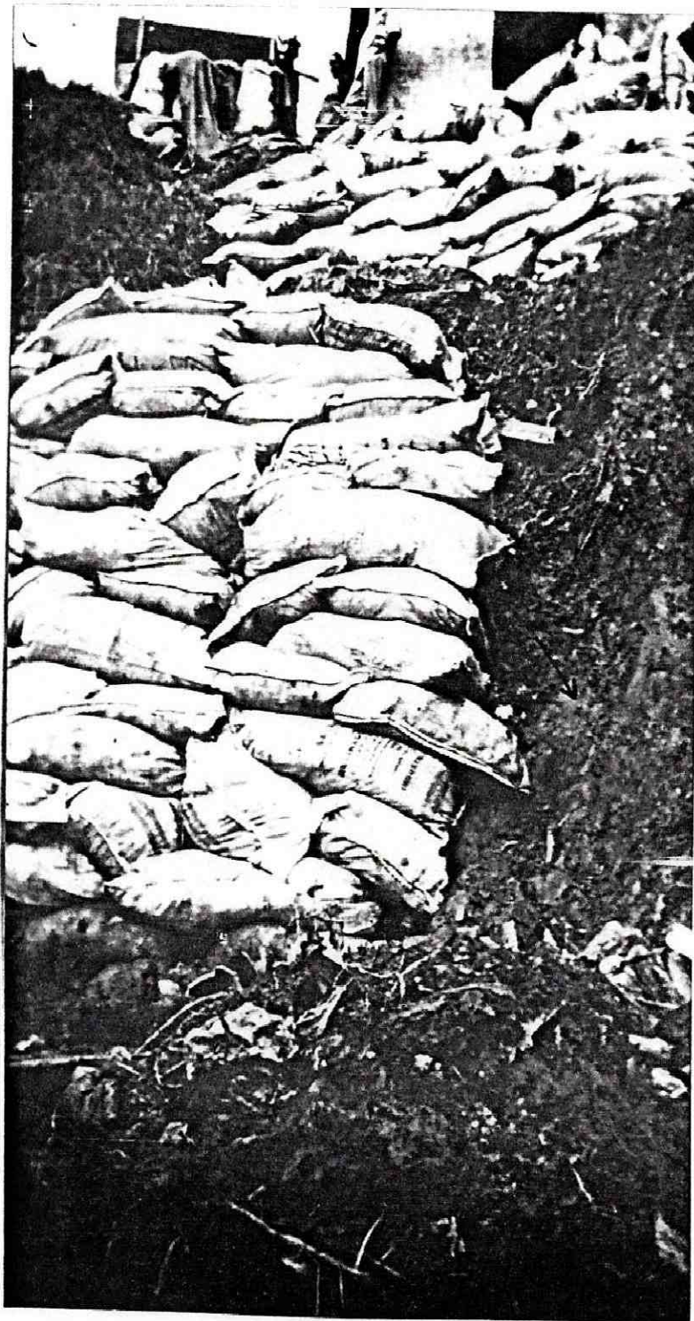
Foto No. 2. El muro en bolsas de tierra armada se hizo en dos secciones; al lado de la sección inferior se alcanza a observar la roca alterada.
