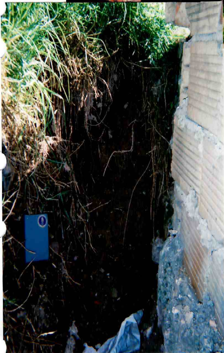
Foto No. 4 Vivienda en construcción con condiciones favorables para el empozamiento de aguas lluvias.
