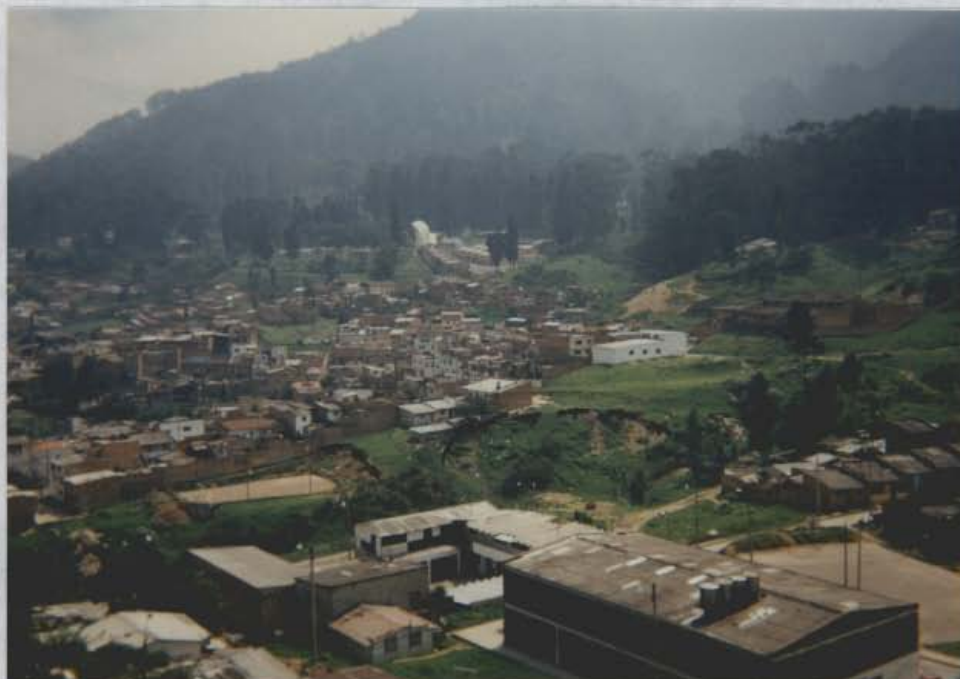
Fotos No. 13 y 14 Deslizamiento en la margen derecha del antiguo cauce de la Quebrada Chorrerón.
