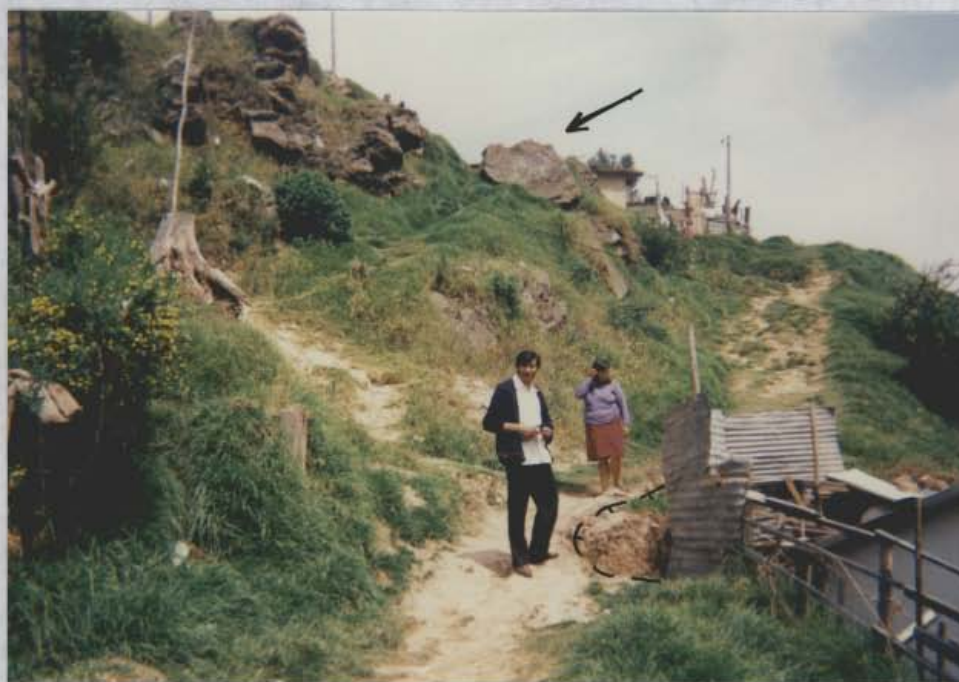
Foto No. 10 Areniscas con intenso diaclasamiento que generan riesgo por desprendimiento de bloques. Obsérvese en la parte superior un bloque suelto que alcanza un diámetro de 1,5 m.
