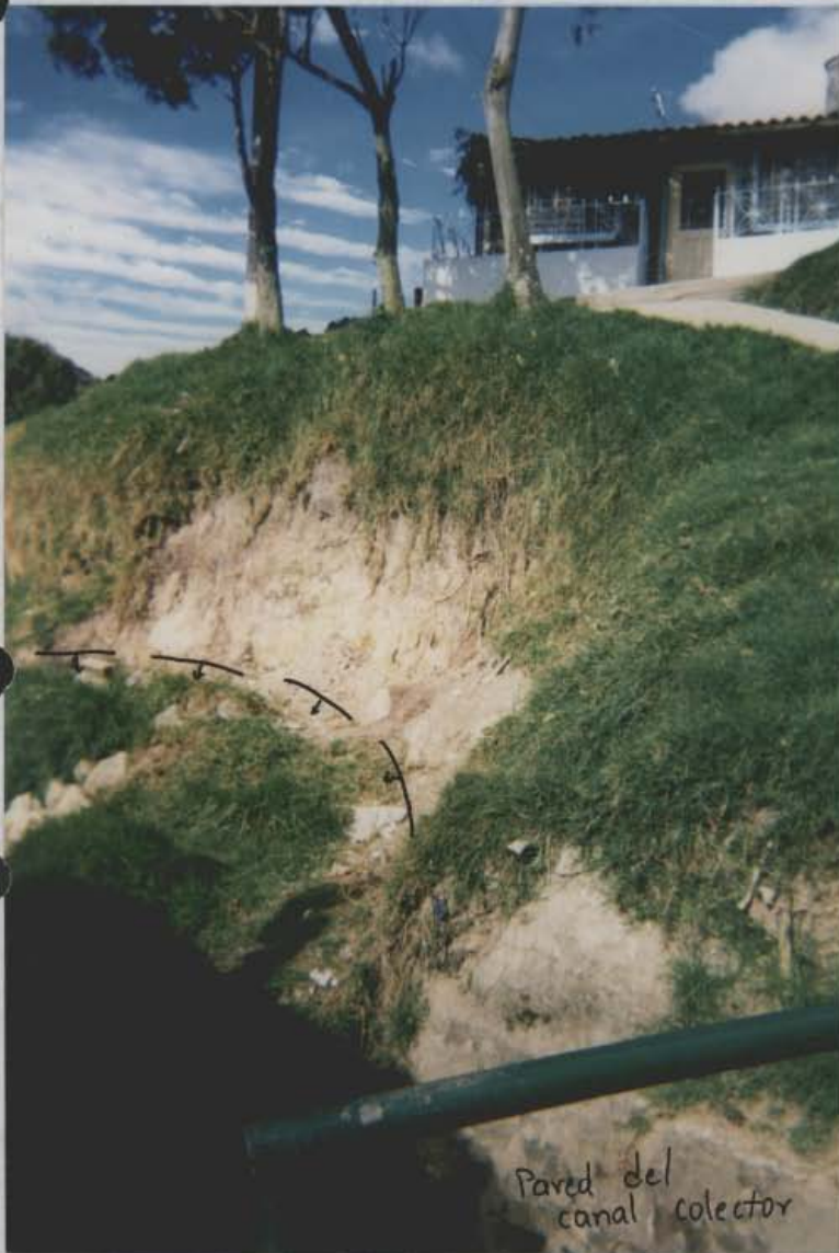
Foto No. 2 Deslizamiento en el borde del canal colector de aguas lluvias. Obsérvese la proximidad de la vivienda.
