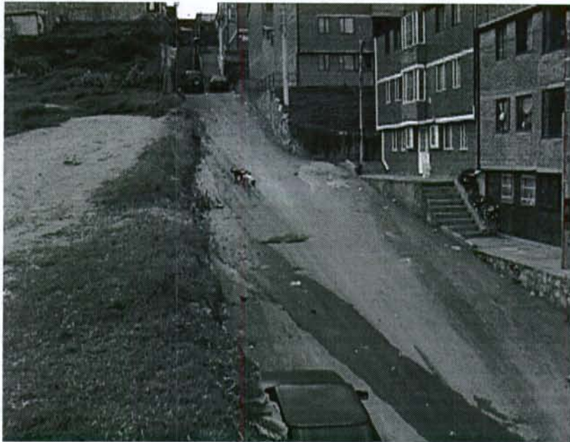
FOTOGRAFIA 1. Corona del talud.
