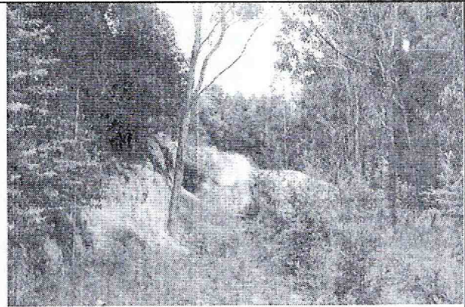
Fotografía No. 2. Vista del sector donde se busca adelantar el proyecto. Talud en el costado oriental con presencia de suelos residuales expuesto con presencia de erosión de media a alta intensidad.
