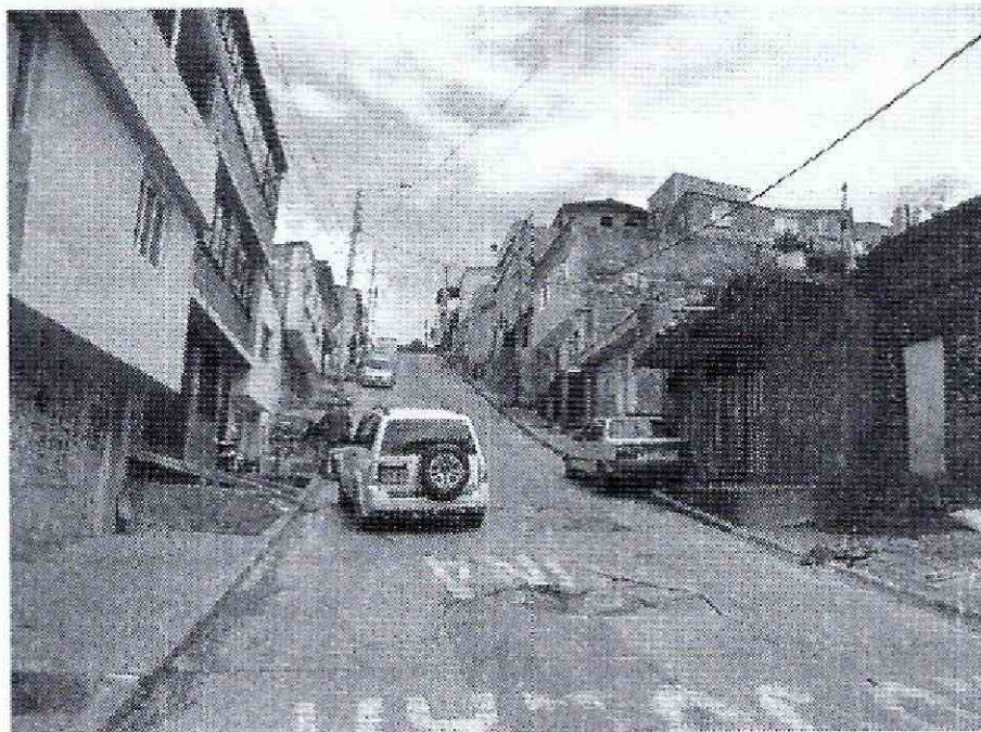
Foto 1. Vista del sector donde se localiza el proyecto de la Calle 30A Sur # 9C-15 Este, Localidad de San Cristóbal.
