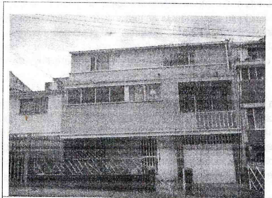
Fotografía No. 3. Vista del predio en donde se desarrollará el proyecto de la Carrera 5 No. 46 – 61, en la localidad de Chapinero.
