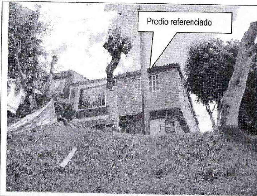
Fotografía No 1. Predio objeto de visita. Vivienda de dos pisos. Existe retiro prudente con una pendiente la cual se encuentra estabilizada al momento de la visita.
