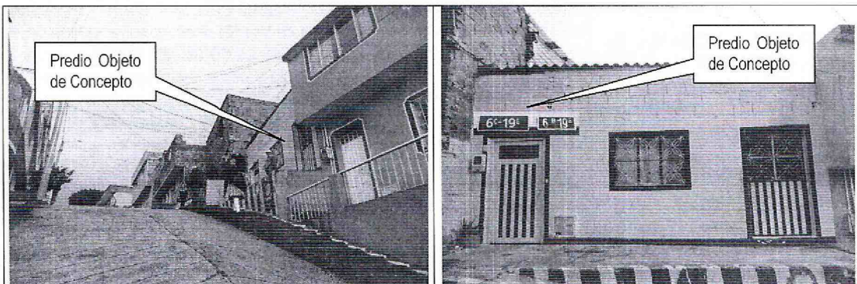
Fotografía No. 1. Panorámica del predio objeto de visita en donde se evidencia un sector consolidado cuyo uso varía principalmente residencial. Fotografía No. 2. Predio objeto de visita en el cual se encuentra construida una edificación de un (1) piso de altura.
