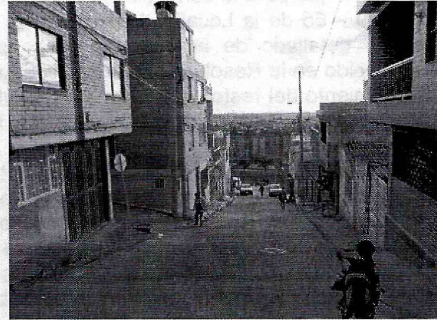
Fotografía No. 2. Vista del sector donde se localiza el proyecto de la Carrera 84C No. 145 - 71, donde se evidencia un sector consolidado cuyo uso es principalmente residencial.
