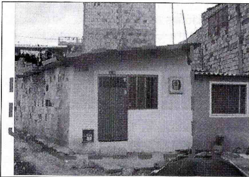
Fotografía No. 1. Vista del predio ubicado en la Diagonal 49F Sur No 12 - 54 del Sector Catastral El Playon de la Localidad de Rafael Uribe Uribe, donde se desarrollará el proyecto.
