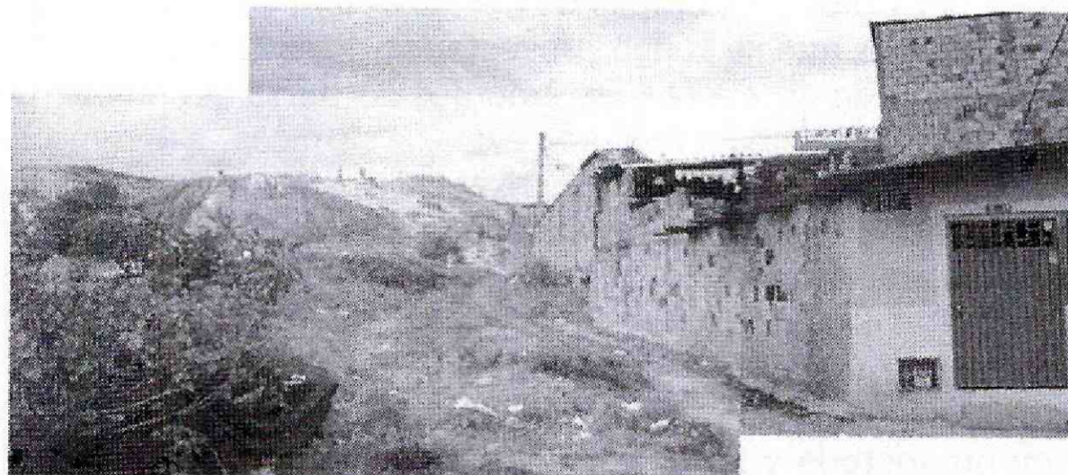
Fotografía No. 3. Vista de la Carrera 12A Bis. Se observa un sector que corresponde a una antigua cantera de explotación de material para construcción. Al momento de la visita no se observaron evidencias de procesos de remoción en masa activos.
