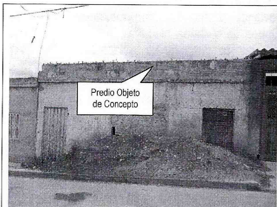
Fotografía No 1. Predio objeto de visita en el cual se encontró una edificación de un (1) nivel. Con un cerramiento en muro y material acumulado en el andén.
