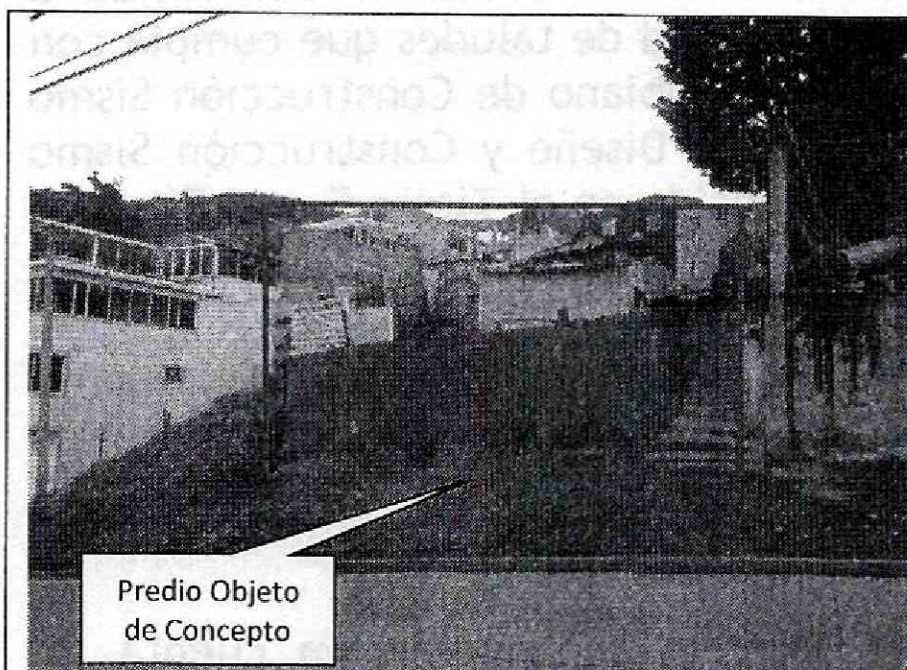
Fotografía No 1. Predio objeto de visita en el cual se encontró un lote con cerramiento en tejas, dentro del cual se encontró una construcción en madera y otra en mampostería simple.
