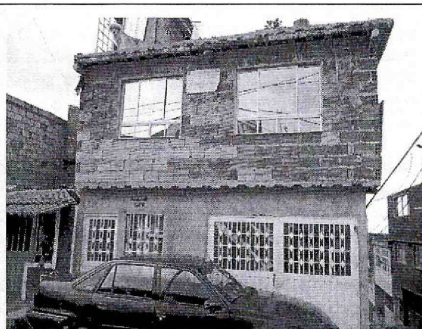
Foto 2. Predio en donde se desarrollará el proyecto ubicado la Carrera 12A Este No 32C-49 Sur, Localidad de San Cristóbal.
