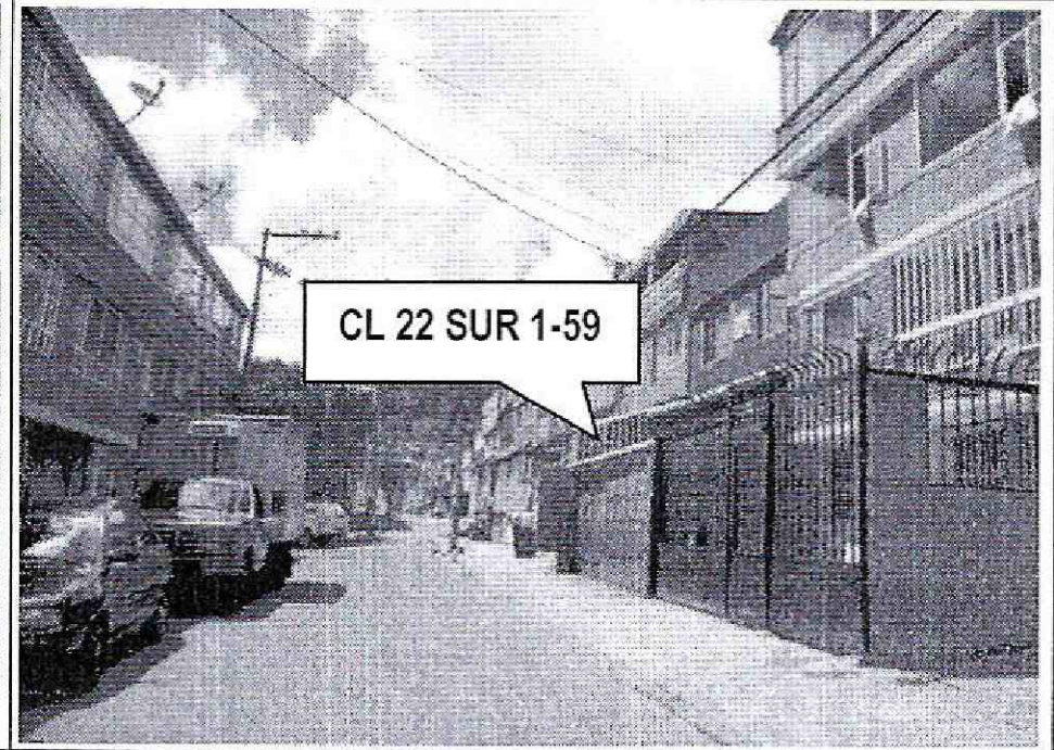
Fotografía 2. Vista del sector entorno del predio de interés, muestra un sector consolidado con alta densidad de construcciones.
