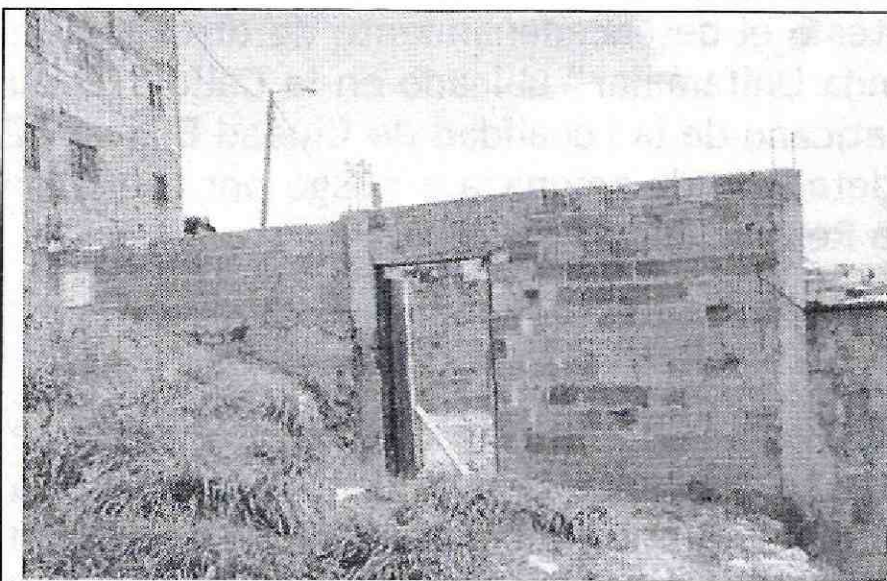
Fotografía No. 4. Vista del predio ubicado en la Calle 81C Sur No 17A - 58 del barrio San Joaquín el Vaticano, de la Localidad de Ciudad Bolívar donde se desarrollará el proyecto. Se observa una construcción de 1 piso de altura.
