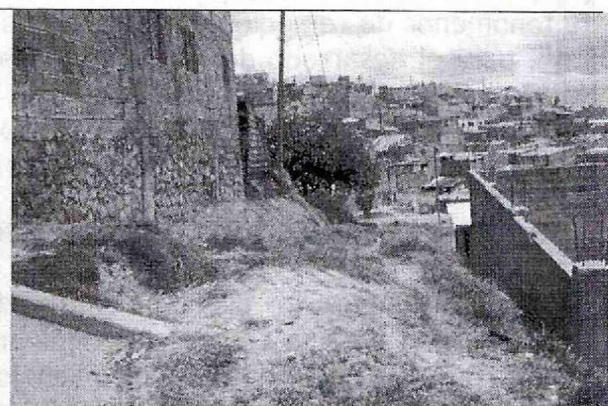
Fotografía No. 5. Vista de la Carrera 17D. Se observa una zona de pendiente media en un sector en proceso de consolidación donde predominan las edificaciones de un piso en mampostería sin confinar.
