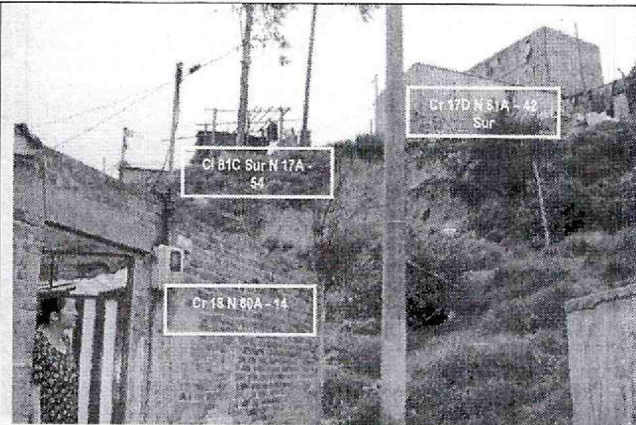
Fotografía 3. Se realiza una comparación temporal del avance del proceso, y de las condiciones espaciales. Se observan las viviendas sobre las cuales se emitieron actas, y que presentan un alto riesgo por el proceso avance retrogresivo del PRM. (Tomada del DI-5104) Septiembre de 2013.
