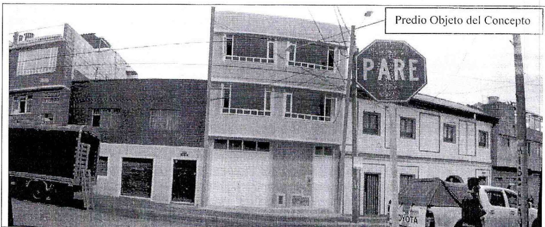
Fotografía No. 1. Panorámica donde se puede observar el predio objeto de la visita técnica y los tipos de edificaciones circundantes
