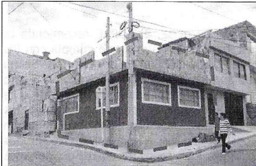
Fotografía No. 1. Vista del predio ubicado en la Carrera 3D Este No 47B - 26 Sur del Sector Catastral Canadá o Guira de la Localidad de San Cristóbal donde se desarrollará el proyecto.
