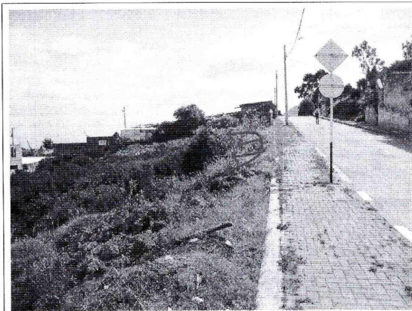
Foto 3. Sector donde se identificó un proceso de remoción en masa de carácter local al interior del predio de la Carrera 12 Este # 65-74 Sur, Localidad de San Cristóbal.
