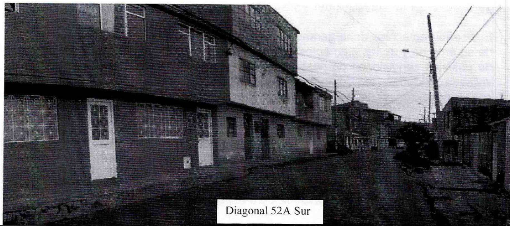
Fotografía No. 2. Vía pavimentada correspondiente a la Diagonal 52A Sur, sobre la cual se ubica el predio objeto del concepto técnico, también se puede observar los tipos de edificaciones existentes.
