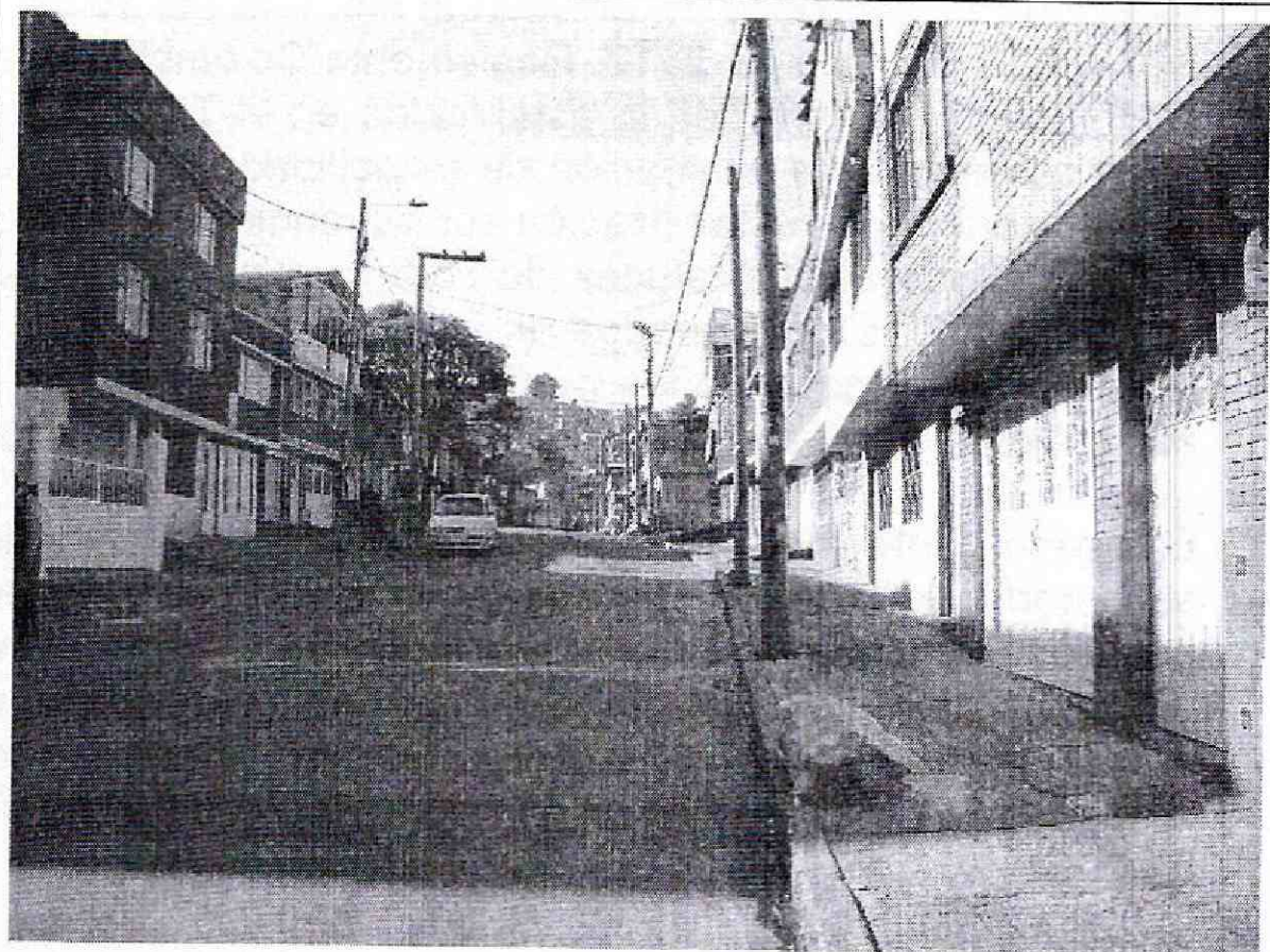
Foto 2. Vista del sector donde se localiza el proyecto de la Carrera 10B Este # 24-34 Sur, de la Localidad de San Cristóbal.
