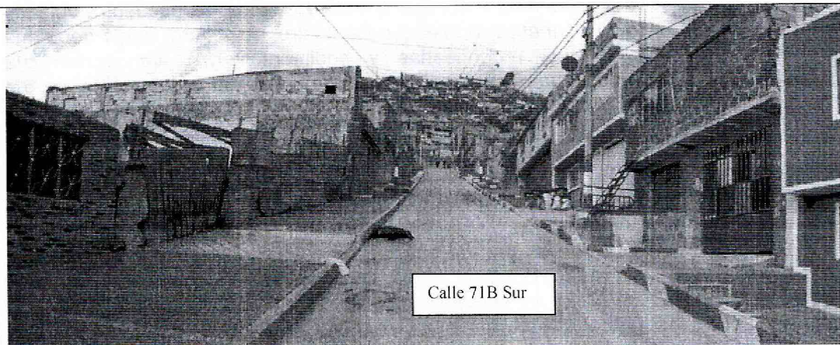
Fotografía No. 2. Condiciones de Calle 71B Sur sobre la cual se ubica el predio, también se pueden observar los tipos de edificaciones existentes.
